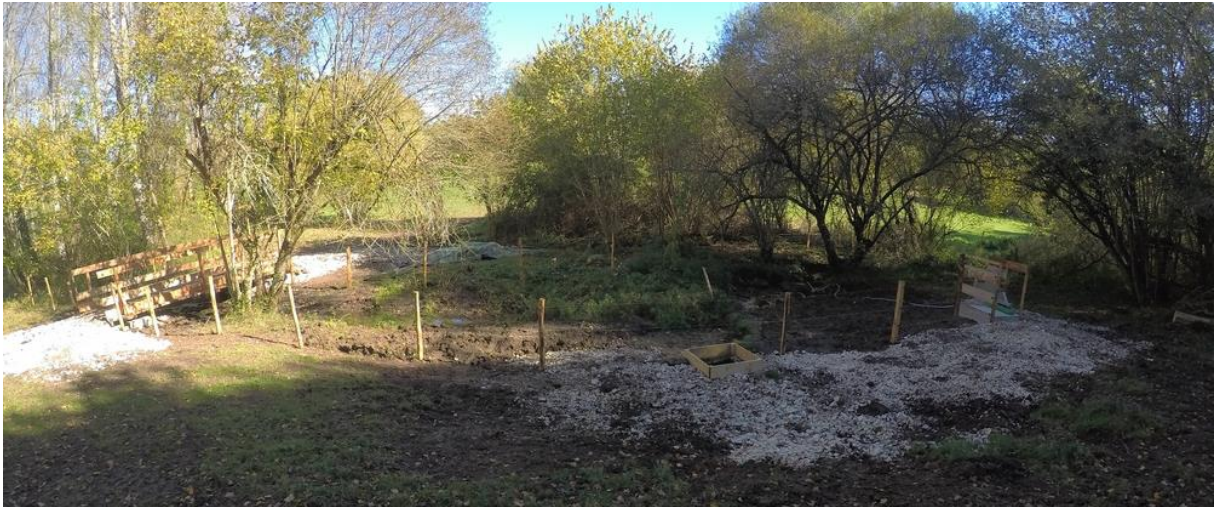
Figure 11 : Tronçon du cours d'eau (la Sandonie) aménagé
