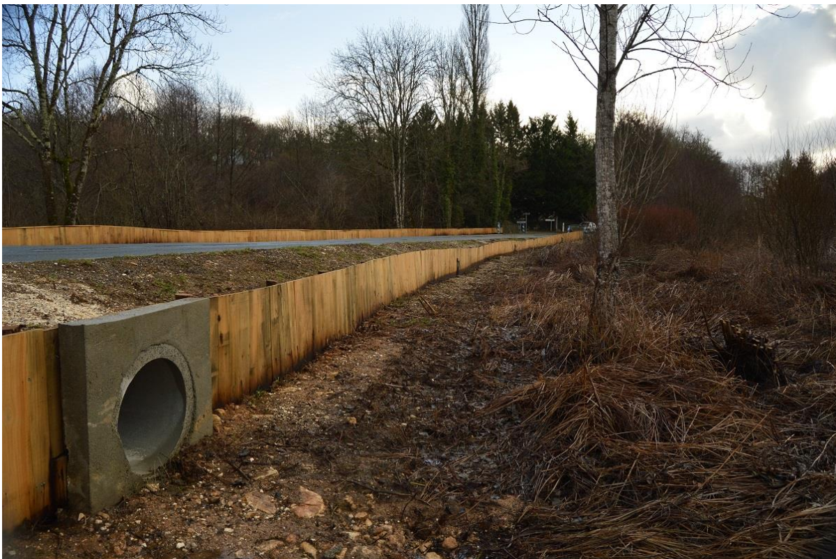
Figure 12 : Dispositif de franchissement en faveur des mammifères semi-aquatiques
