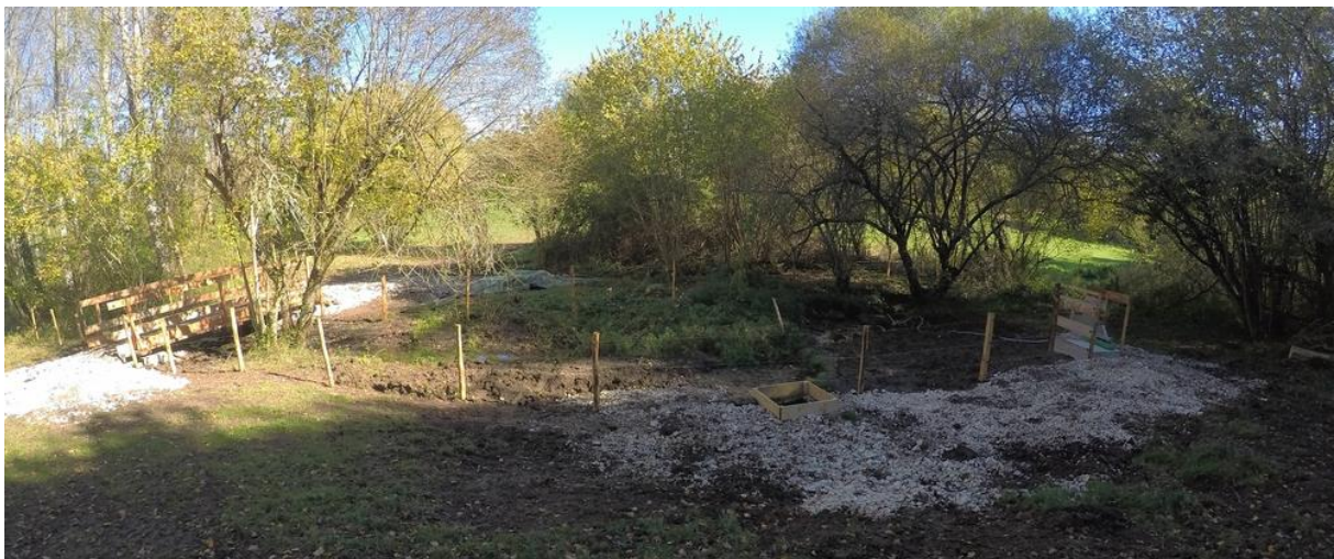
Figure 10 : Tronçon du cours d'eau (la Sandonie) aménagé
