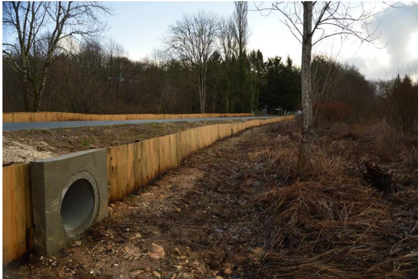
Figure 11 : Dispositif de franchissement en faveur des mammifères semi-aquatiques
